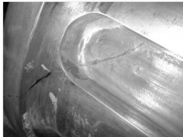
原子力4極発電機のシャフトキーウェイ内のねじりき裂
