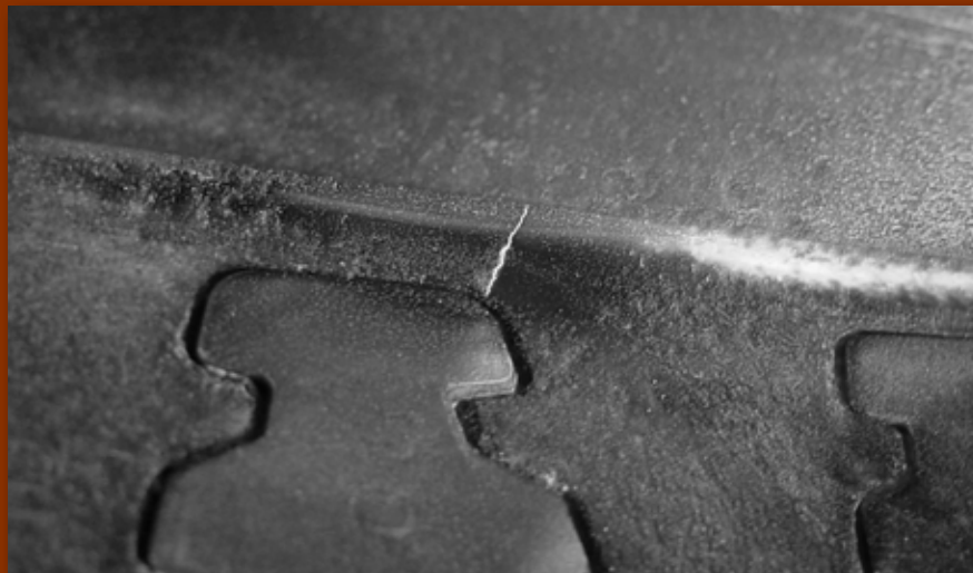
き裂した軸方向挿入型ディスク羽根アタッチメント
