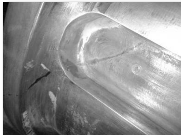
Fissuration de torsion dans la rainure de clavette de l'arbre du rotor d'un générateur nucléaire tétrapolaire
