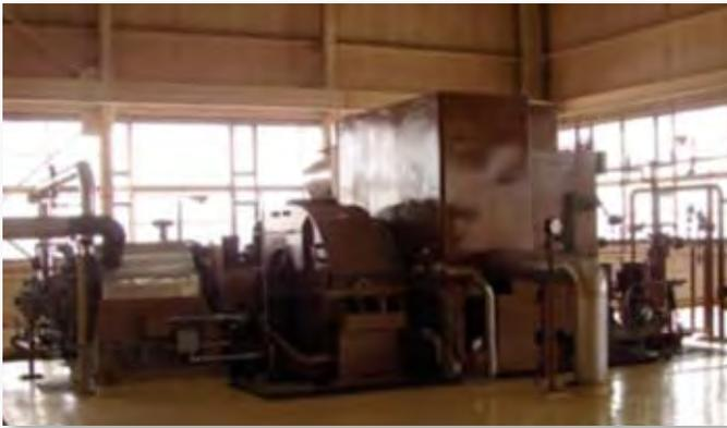
*Installation type de turbine-pompe d'alimentation de chaudière*
